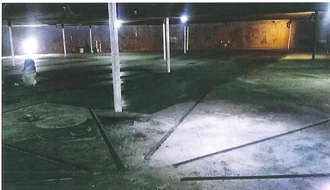
Interno serbatoio A realizzazione doppio fondo
