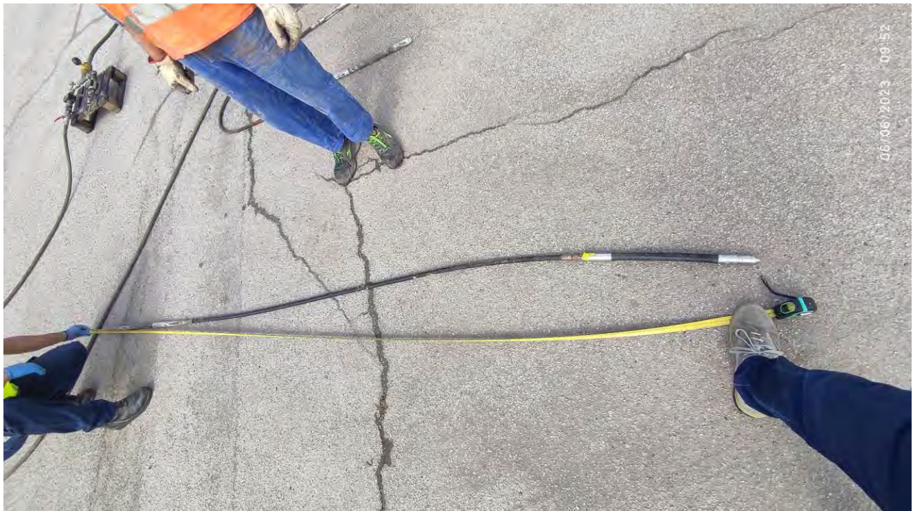
Particolare del sistema di iniezione – Pressurizzazione doppio packer
