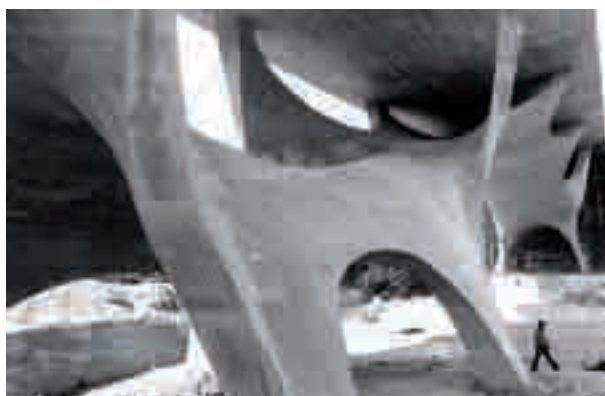
Ponte Musmeci a Potenza foto di Cartier-Bresson 1973
